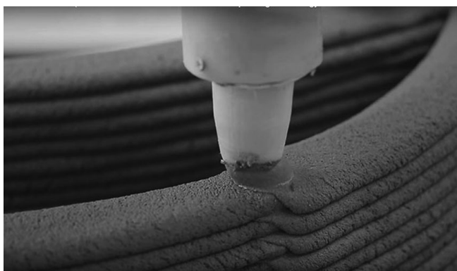
Рис. 6 Подача бетонной смеси. Фото с электронного ресурса www.3dnatives.com
