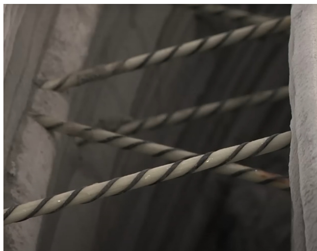
Рис. 7 Соединение внутреннего и внешнего слоев стены, напечатанной на 3D принтере.
